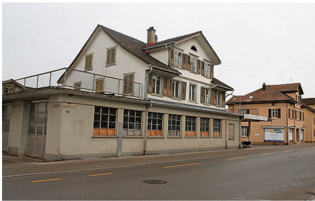
Die alte Autowerkstatt an der Bahnhofstrasse und die Gebäude dahinter werden abgebrochen.
